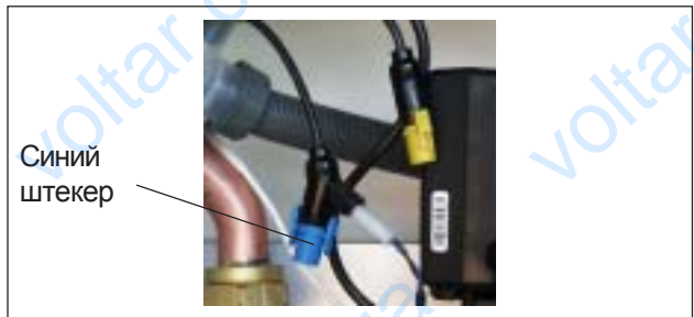
рис.: Синий штекер для подключения датчика температуры бойлера
