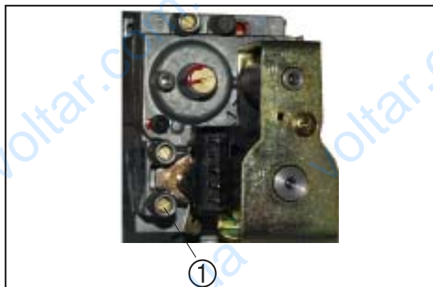
рис.: Проверить давление подключения газа
