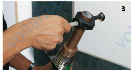
С началом нагрева ремонтного стержня медленно без поворота, вставить штырь насадки в подготовленное отверстие. Время нагрева – 5 сек.
