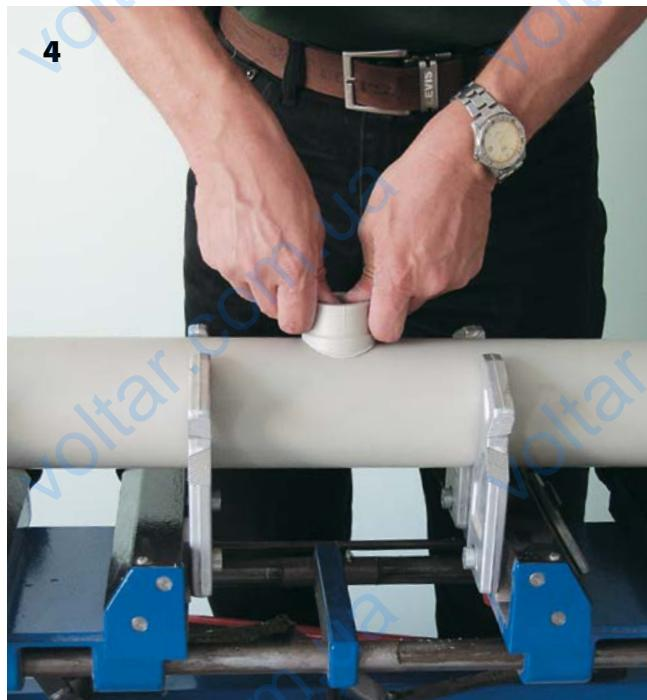
Нагретое седло всунуть в нагретое отверстие и зафиксировать примерно на 16 с. Через час систему можно заполнить водой и нагрузить давлением.
