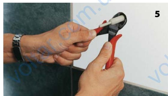
После охлаждения лишнюю часть стержня обрезать ножницами.
