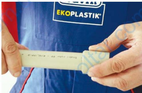
**10/** По окончании нагревания снимаем трубу и фитинг с насадки и соединяем их медленным, равномерным движением без осевого поворота, насадив трубу на фитинг на всю глубину до отметки.
