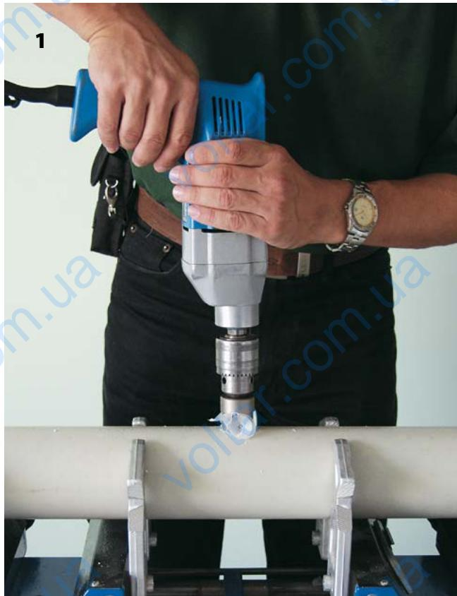
Специальной фрезой высверлить отверстие для седла
