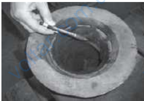
Чистка нагара с горелки (если топиться pellets)
