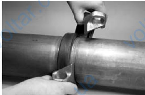
4. Совместите концы труб по одной линии и сведите их вместе. Сместите уплотнение в требуемое положение и удостоверьтесь в его расположении строго по центру между пазами на каждой трубе. Удостоверьтесь, что ни одна из частей уплотнения не попадает в паз любой из труб.
